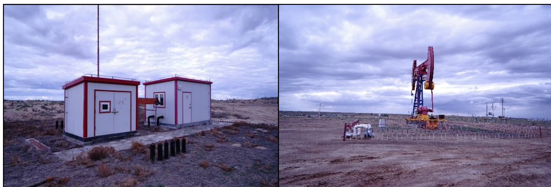
某计量站临时占地植被恢复及永久占地地面硬化情况
