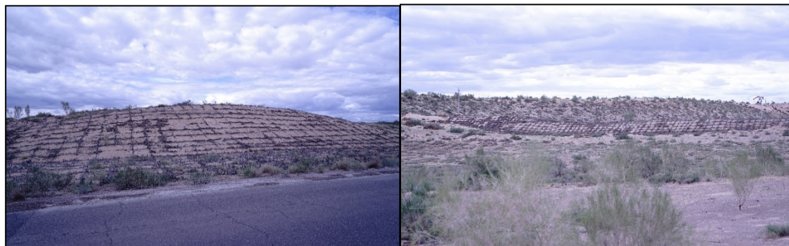
已建道路边坡草方格
